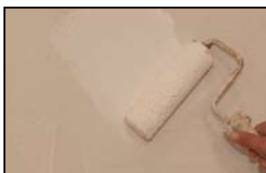
Etape 1 - application au rouleau de la sous-couche d'accroche Argilus.
