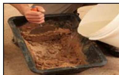
Etape 2 - préparation et humidification de l'enduit (spatule ou malaxeur)
