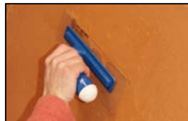
Etape 4 - à mi séchage, resserrer l'enduit à l'aide d'une spatule plastique souple.
